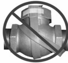
C.) Falsche Montage: Heizband überlappt sich
